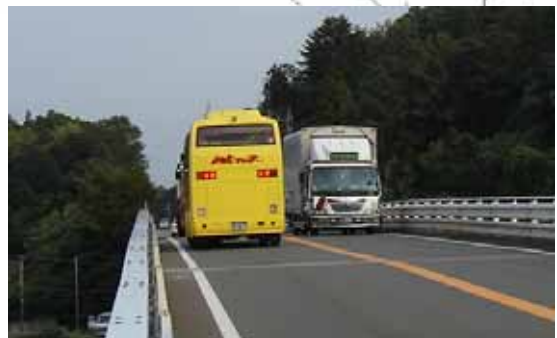
花房跨線橋より富山方面を望む
