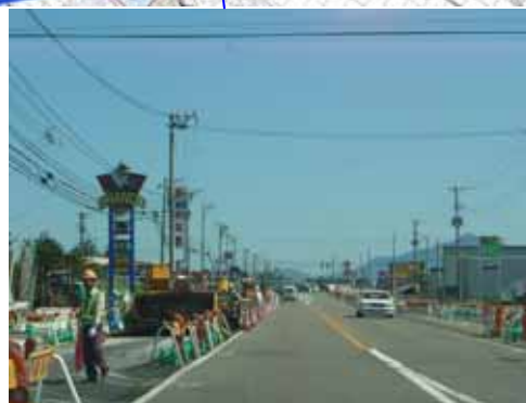
暫定2車線供用中の下荒浜付近の状況 (下荒浜交差点付近から新潟方向を望む)
