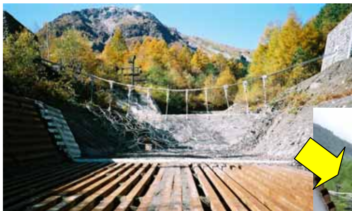
ワイヤーネット工による 土石流捕捉状況 (上高地 上々堀沢)
