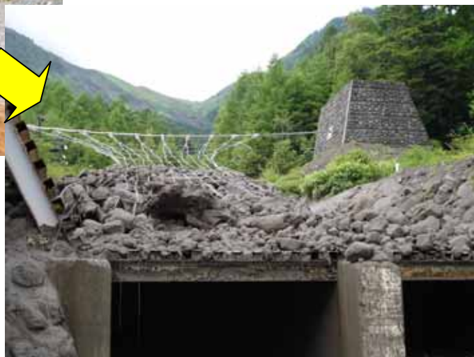
ワイヤーネット工による 土石流捕捉状況 (上高地 上々堀沢)
