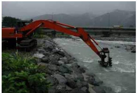
掃流砂観測 大型サンプラーによる流出土砂の採取状況
