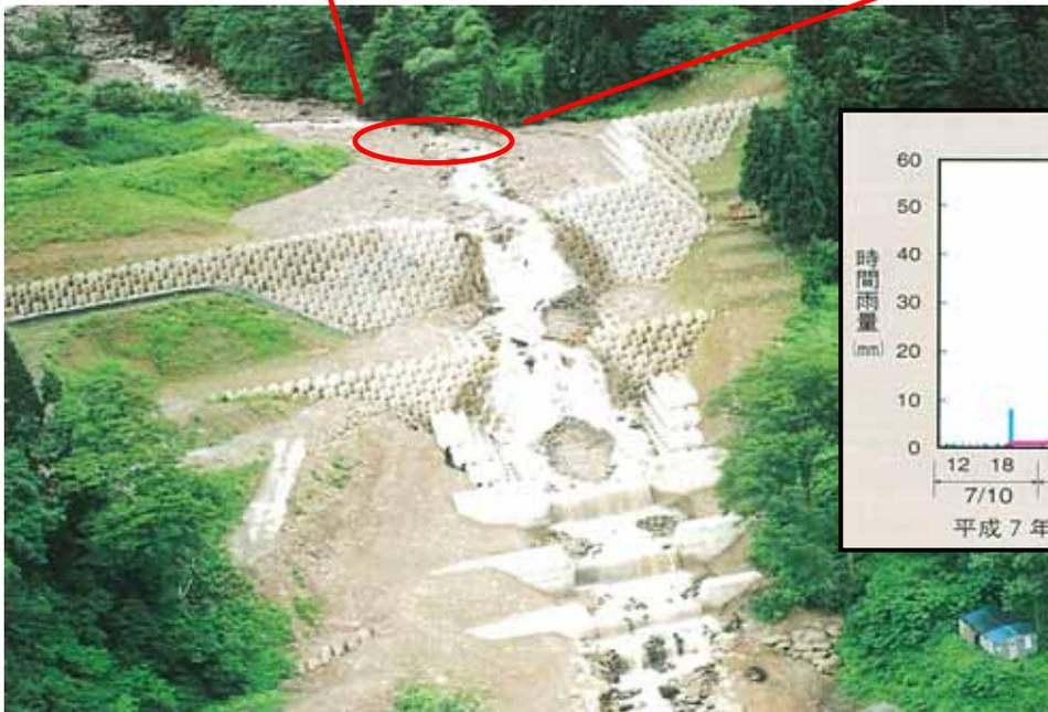
平成7年7月11日洪水で土砂を止めた中股川第1号砂防堰堤
