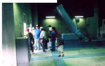
ダム堤体内見学
