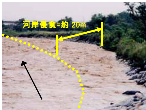
縦工未施工箇所 (右岸8.4k付近)
