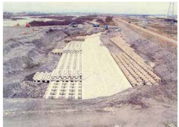
根継工施工状況(H16.3)
