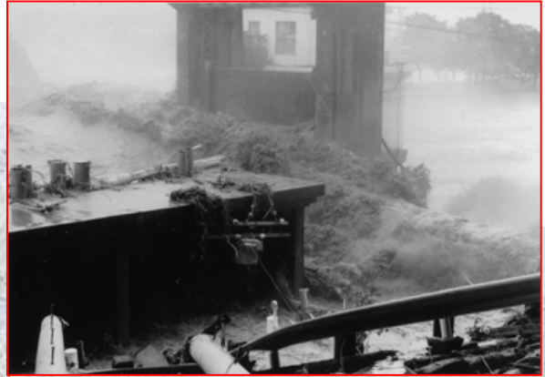
激流にさらされる旧愛本堰堤
