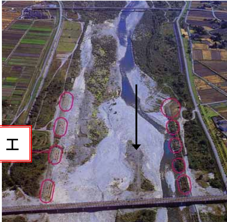
黒部川にならぶ縦工 (権蔵橋より上流を望む)
