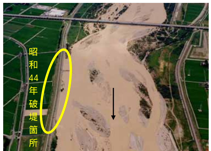
平成7年 出水状況(福島地区)
