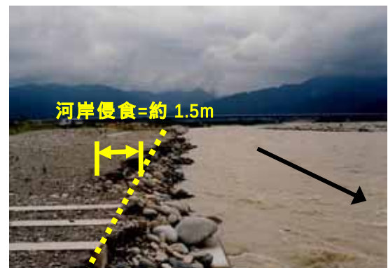
縦工施工箇所 (右岸9.0k付近)
