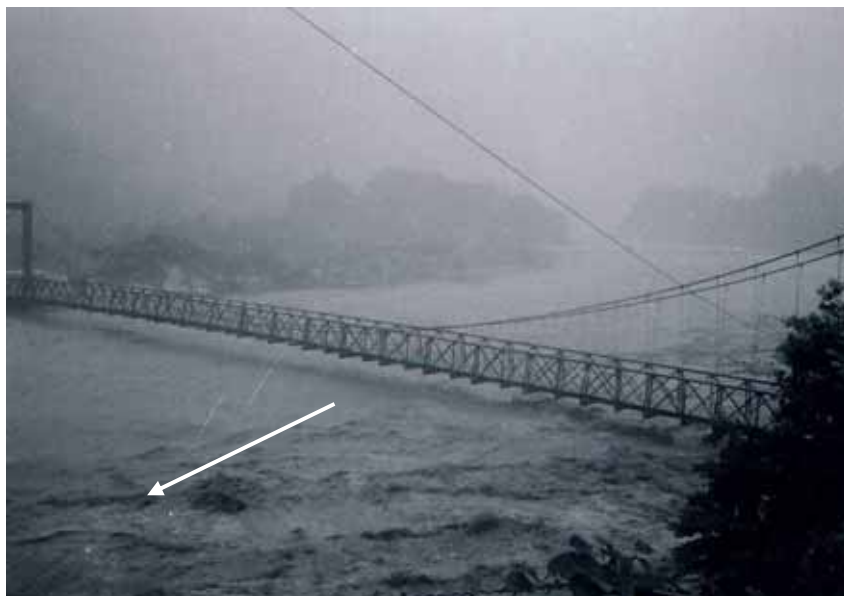
昭和44年8月洪水時の音沢地区 (堤防高-50cm程度まで水位が上昇)
