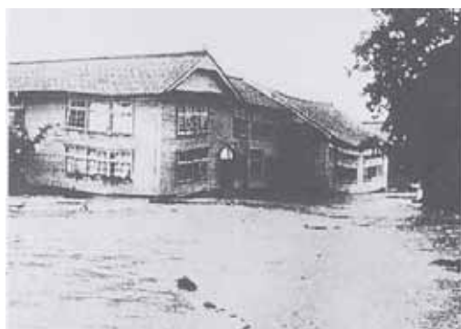
氾濫流による校舍倒壊状況(黒部市村椿地区)
