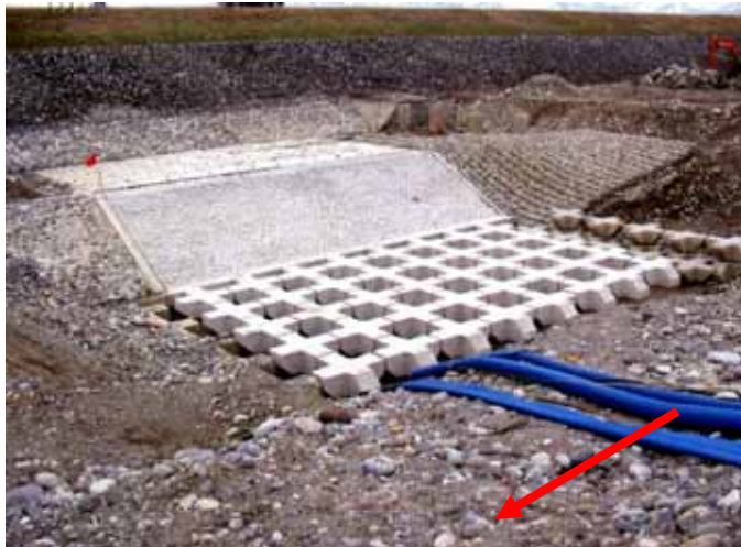
施工中（埋戻前）の状況
