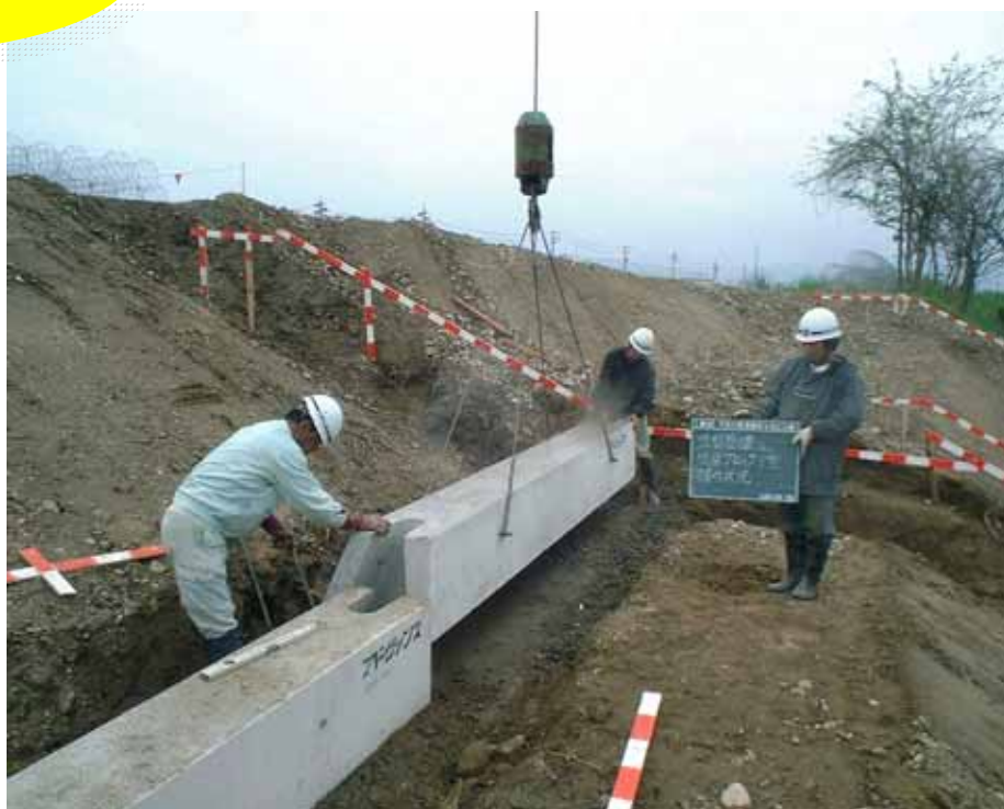
プレキャスト製品の施工状況
