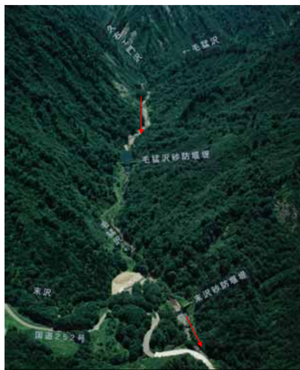
破間川(末沢川) (毛猛沢砂防えん堤・末沢砂防えん堤)
