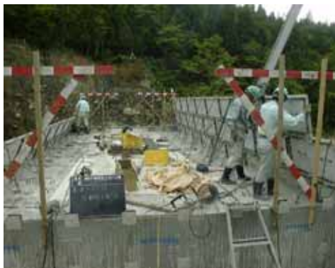
残存型枠設置状況
