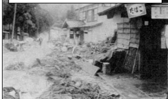
昭和44年災害 三国川野中地区・被害状況
