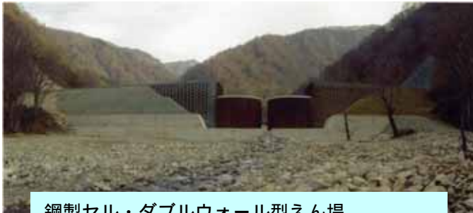
鋼製セル・ダブルウォール型えん堤 (登川上流第2号砂防えん堤)
