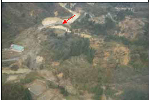
平成16年10月災害 芋川流域で河道閉塞が多数発生
