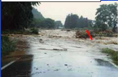
S56.8災害 町道の不通
