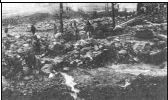
昭和10年災害 魚野川荒廃状況（湯沢町、出水後）
