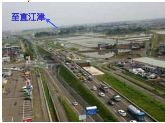
4車線化に向けた鴨島IC付近の状況 (H17供用予定)
