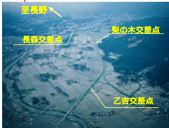
新井・中郷地区の状況 (暫定2車線供用)
