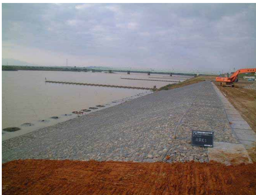
かごマット施工状況
