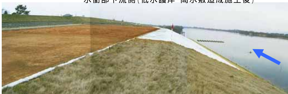
水衝部下流側(低水護岸・高水敷造成施工後)
