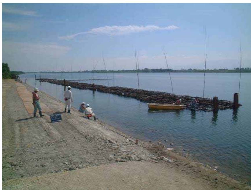
粗朶沈床施工状況(沈設前)
