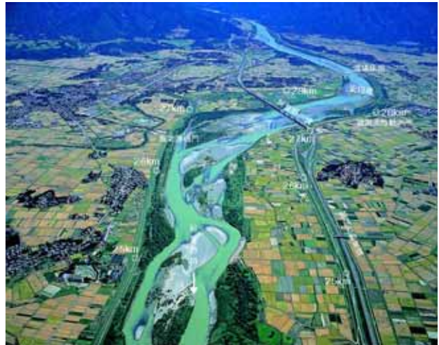
阿賀野川上流部 (25 km付近)
