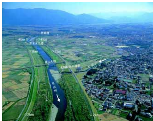
早出川捷水路
