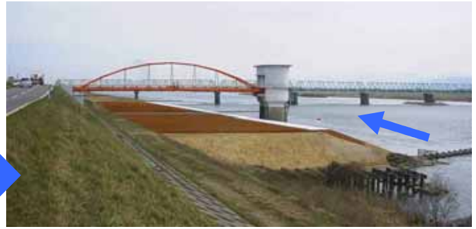
施工後(平成16年3月)
