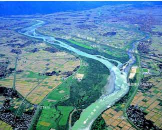
早出川合流点付近 (21 km付近)
