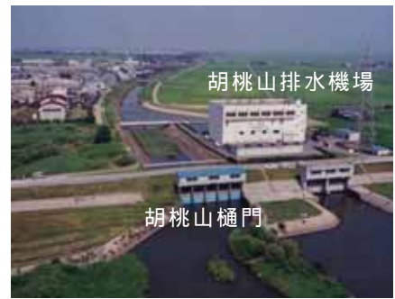
胡桃山排水機場完成
