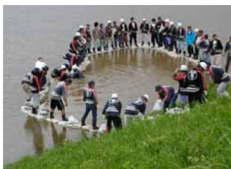
堤防の質的整備(漏水対策) (平成14年7月出水)
