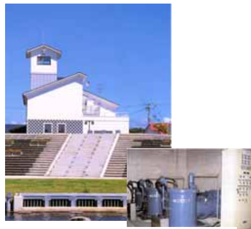
身神川排水機場
