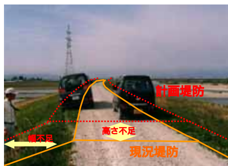
堤防の拡幅・嵩上げ(弱小堤防)
