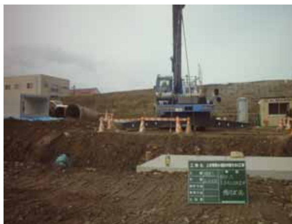
プレキャスト暗渠工据付状況
