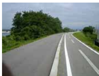
自転車道と共同施工後の堤防
