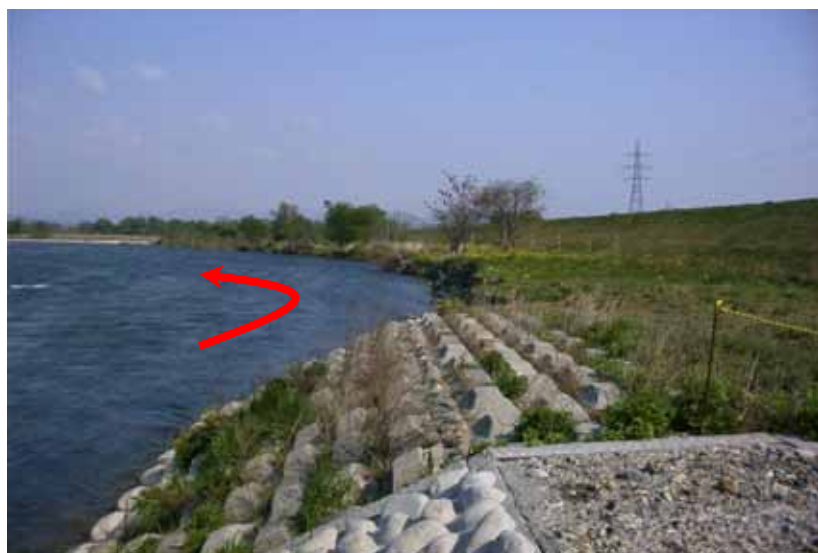
施工前（平成15年5月） 湯川村佐野目地先
