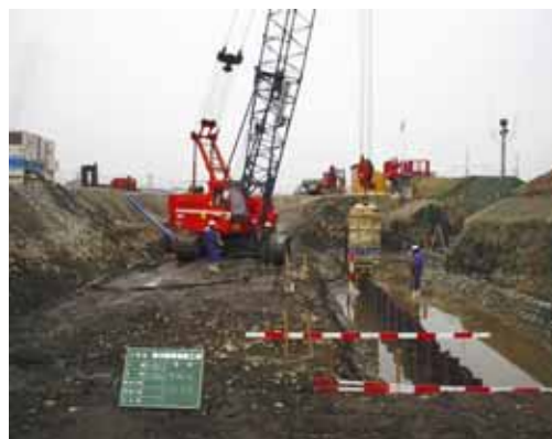
打設状況（湯川樋管改築）
