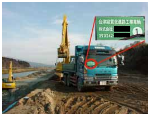
土砂搬出状況
