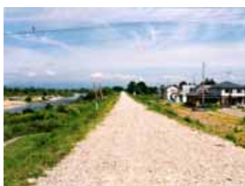
整備前の堤防
