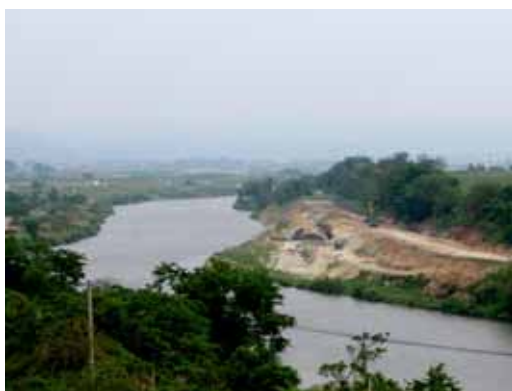
下流狭窄部改修事業（津尻地区）
