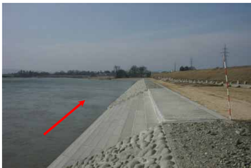
護岸施工後（平成16年3月） 湯川村佐野目地先
