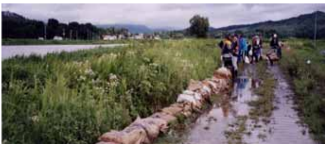
水防活動（旧宮川越水箇所）
