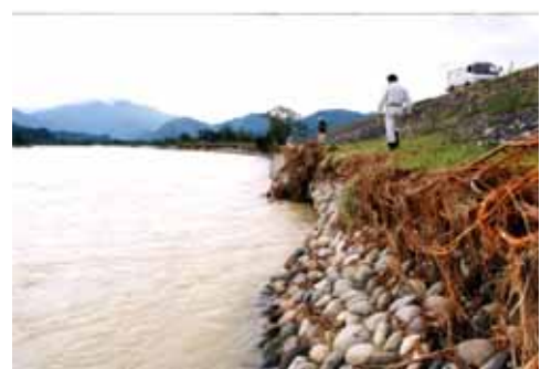
水衝部対策(平成10年9月出水)
