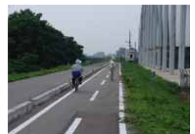
堤防天端の利用状況
