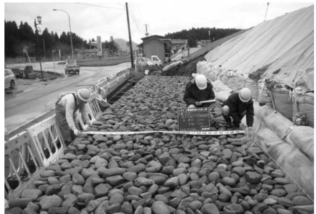
堤防浸透対策の施工事例 (荒川での施工中状況)
