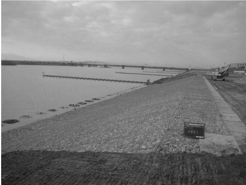
かごマット施工状況
