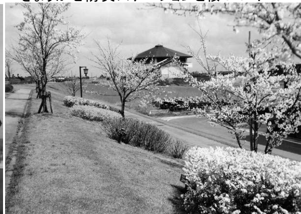
きょうがせ防災ステーションと桜づつみ
