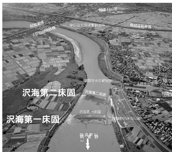
現在の沢海第一床固，第二床固
