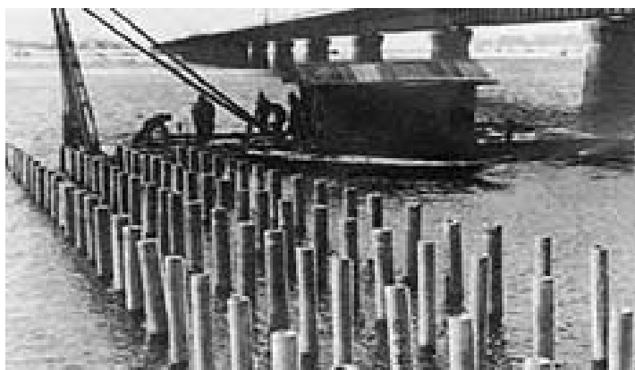
第二期改修工事の様子
