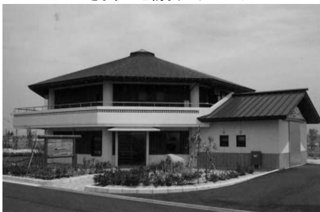
きょうがせ防災ステーション
