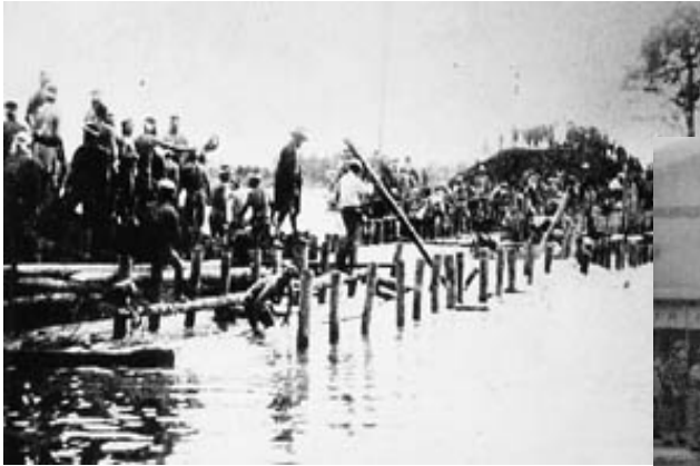
木津の破堤箇所を復旧する様子 (現:新潟市江南区)
