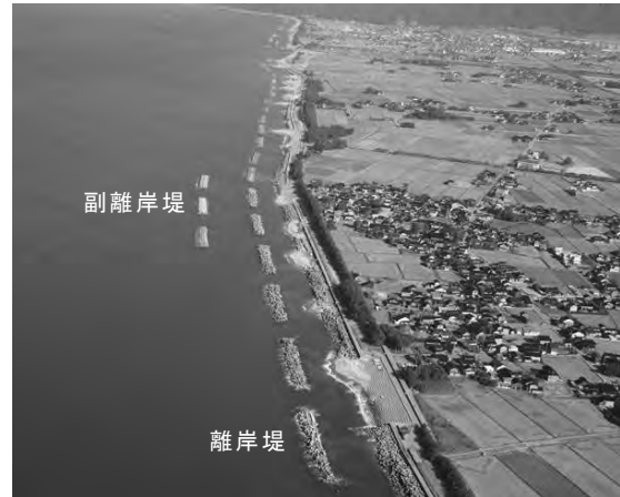
②入善町横山地先(第2工区)
