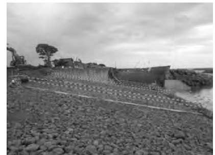
緩傾斜堤の裏込への発生材の再利用
