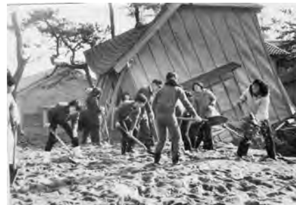
昭和45年2月復旧作業状況(入善町芦崎)
