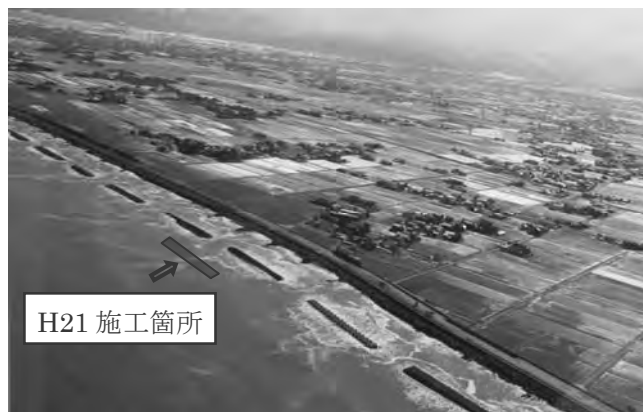
五十里 副離岸堤 平成 21 年度施工
