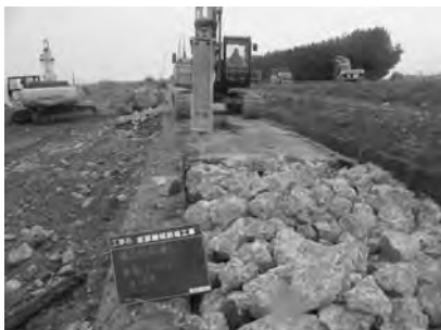
老朽化した直立堤の破碎
