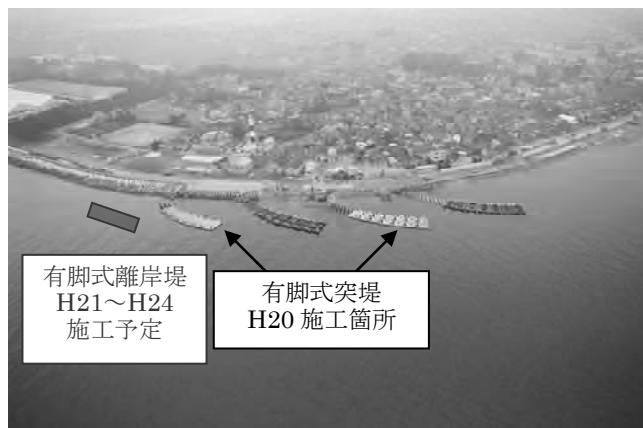
越湖 有脚式離岸堤 平成 21~24 年度施工
