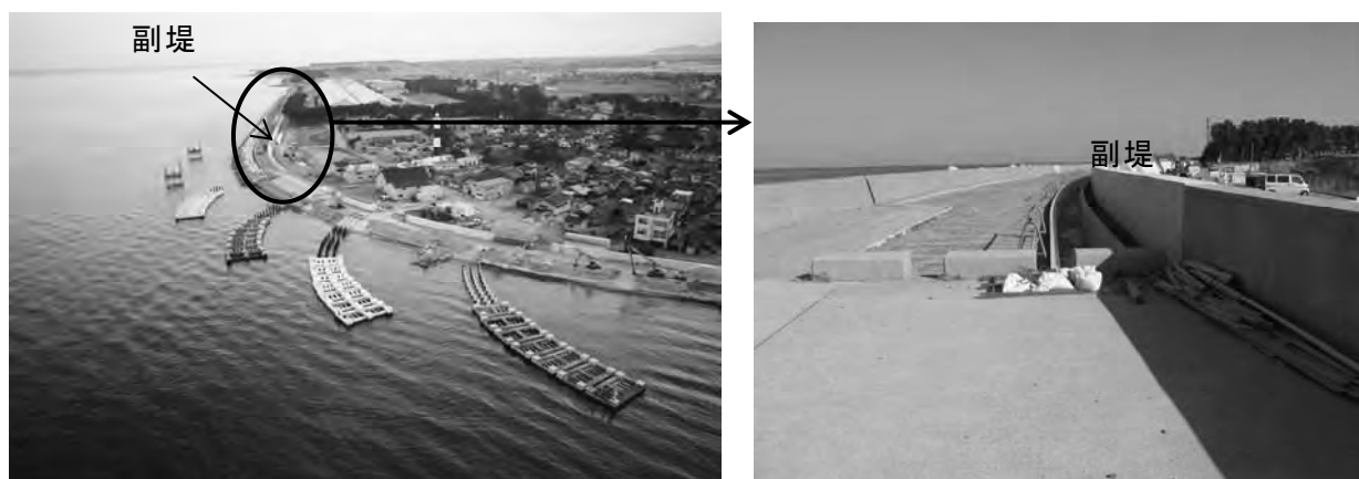
生地 副堤 平成 21 年度施工
