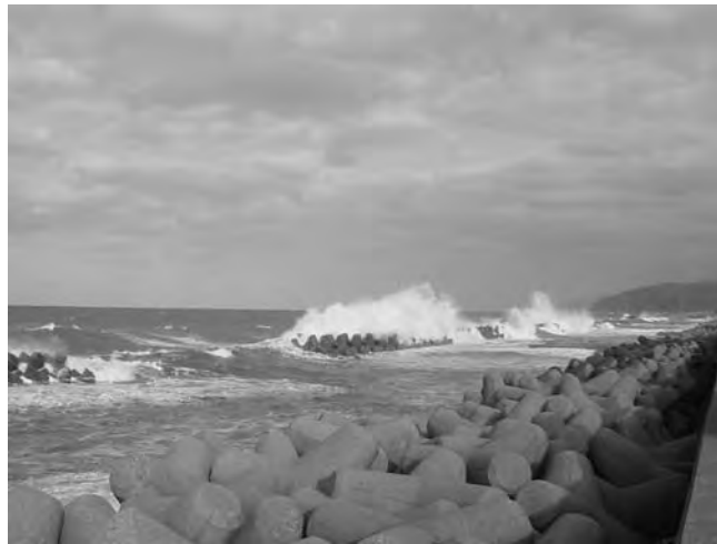
離岸堤の消波状況
