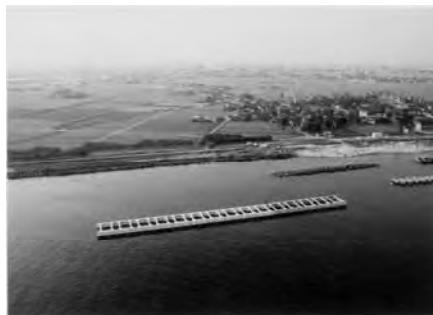
第3工区吉原 有脚式離岸堤
