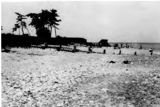
(No.159～No.157 付近) S35 撮影
