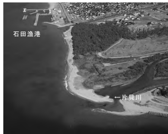
⑥黒部市大島地先(第6工区) 〔片貝川河口〕
