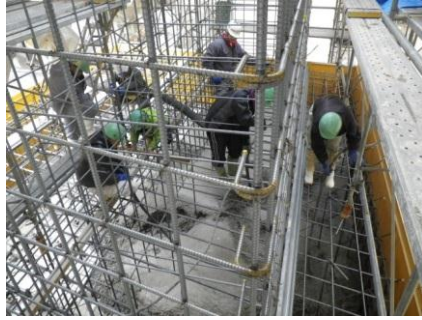
下部工施工状況
