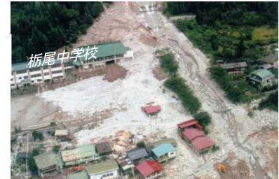
頻発する土砂災害 昭和54年の洞谷災害
