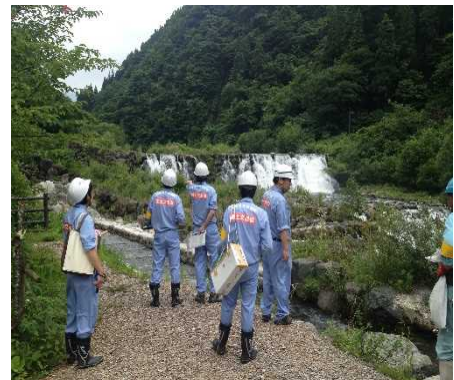
過年度の点検状況
