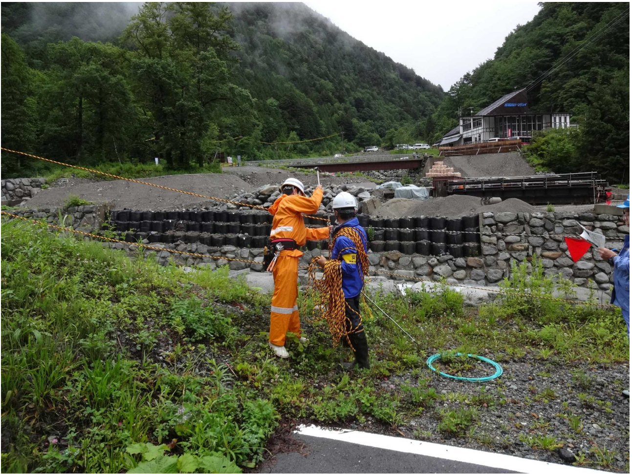
点検の様子（新穂高溪流保全工）
