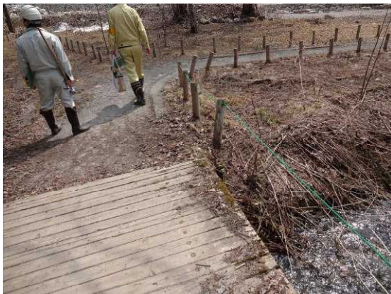
新穂高溪流保全工（緩んでいた防護柵を打ち込み直し）
