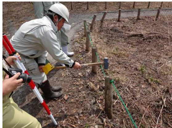
新穂高溪流保全工（緩んでいた防護柵を打ち込み直し）
