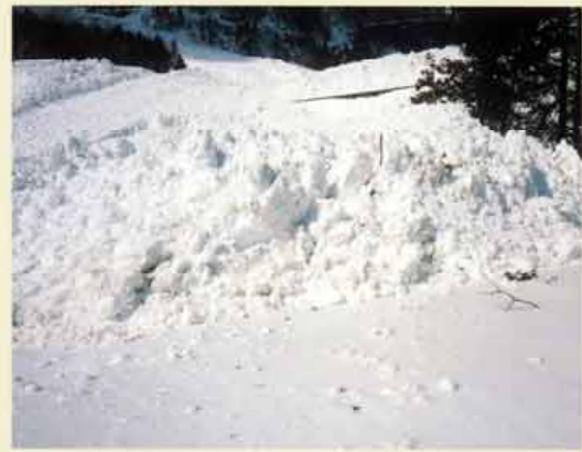
左俣谷第1号砂防ダム直下
