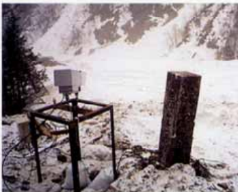
左俣谷第1号砂防ダム付近
