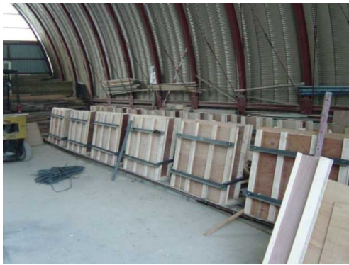
型枠ブロック施工
