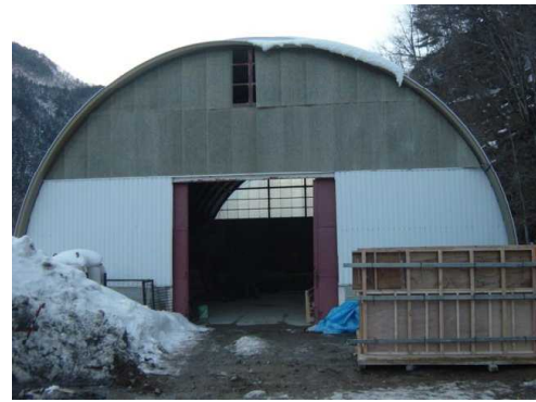
型枠ブロック施工場
