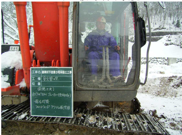
アクリル板 取付け状況
