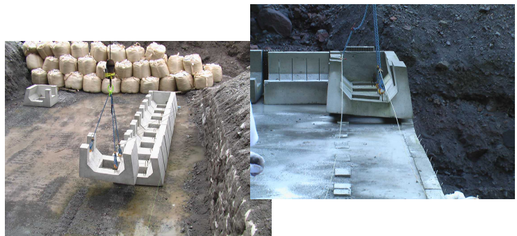
クレーンによる据付状況
