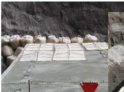
無人養生マット布設状況 散水状況
