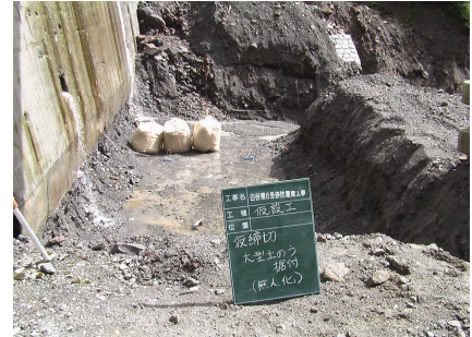
クレーンによる土嚢据付状況
