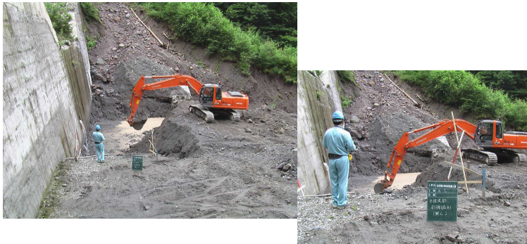
無人化バックホウによる掘削状況
