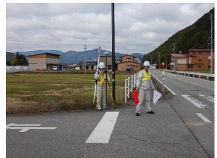
図5 標定点測量作業
