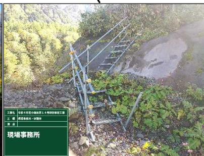
避難通路出口昇降階段
