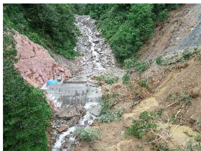
【令和2年 14号堰堤左岸側斜面崩落】
