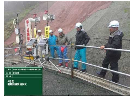
第1避難場所（現場）
