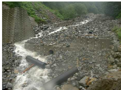
【令和2年 14号堰堤左岸側斜面崩落】
