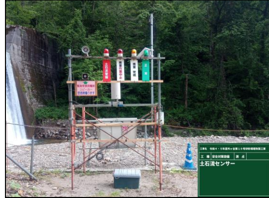
【現場サイレン設置状況】
