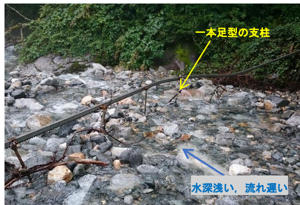
右俣谷 出水後の状況（2015年9月）
