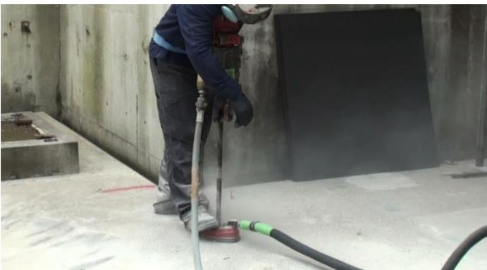
従来の削岩機を使用した人力削孔状況イメージ図
