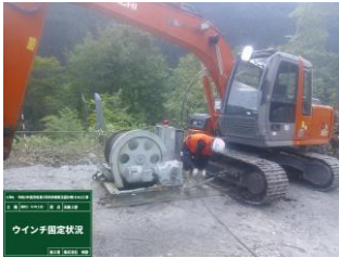
＜ウインチ設置・固定＞
