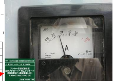
＜アンカー引張試験 (荷重確認)＞
