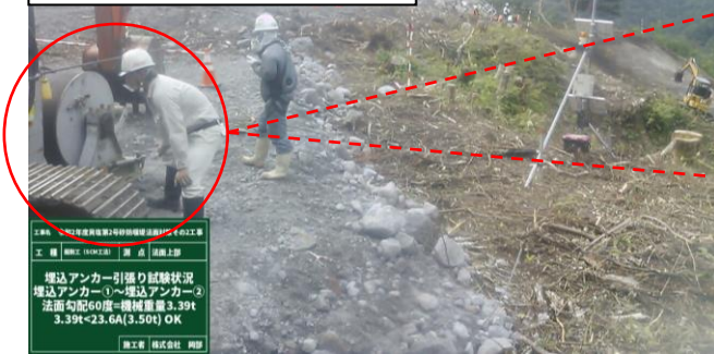
＜アンカー引張試験 (荷重確認)＞
