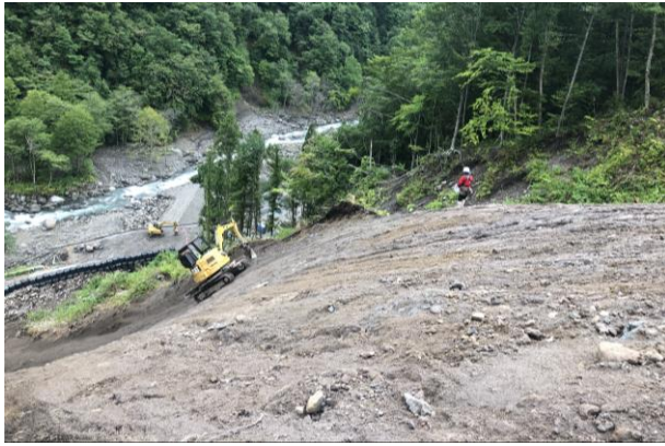
<SCM 工法施工状況>
