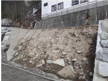
モルタル吹付施工前
