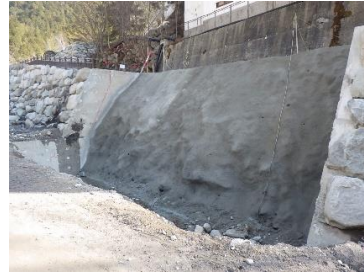
モルタル吹付施工後
