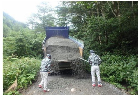
空調服を着用しての作業状況
