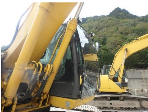
ポリカーボネートプレート取付
