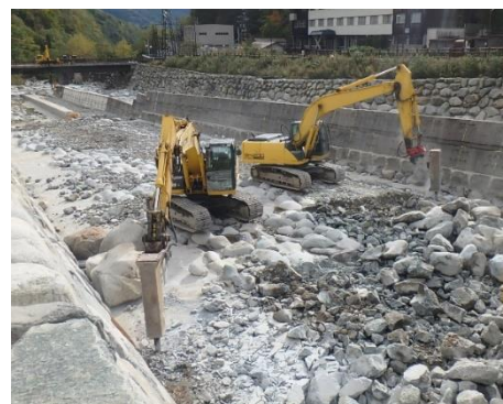
コンクリート取壊し状況
