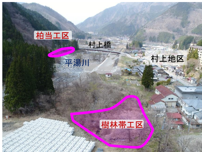
施工箇所全景
