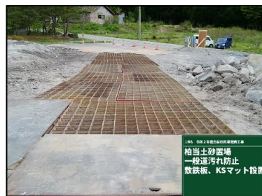
【写真-21 敷鉄板・KSマット敷設】
