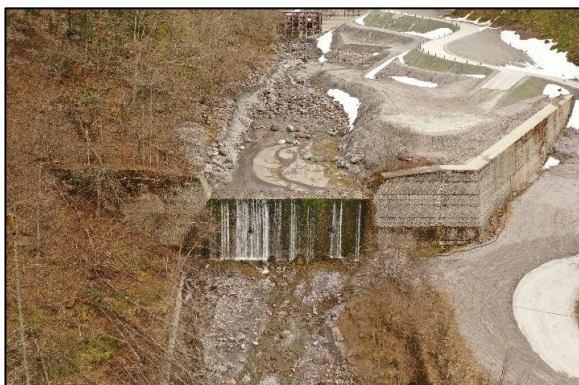
写真-1 白谷第1号砂防堰堤 着工前
