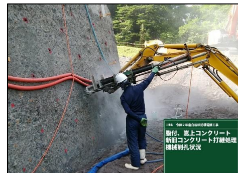
【写真-4 削孔 自社製作 重機取付式削岩機】
