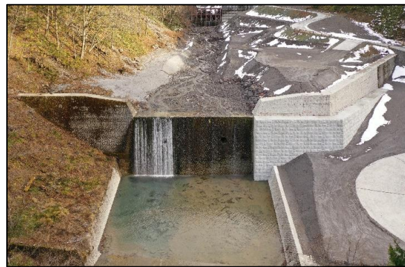
写真-2 白谷第1号砂防堰堤 今年度完成
