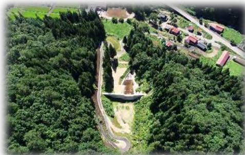
上流より下流を望む
