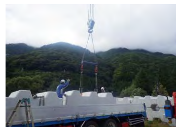
《荷卸し作業状況》
