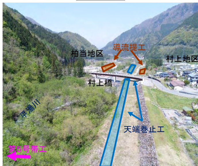
施工箇所全景
