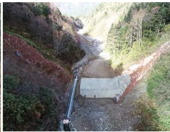
上流より下流を望む
