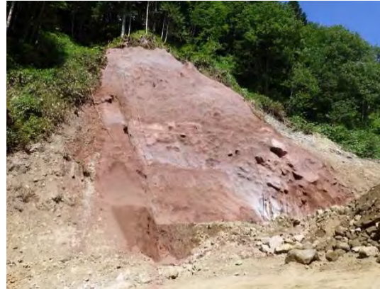
2回目モルタル吹付完了
