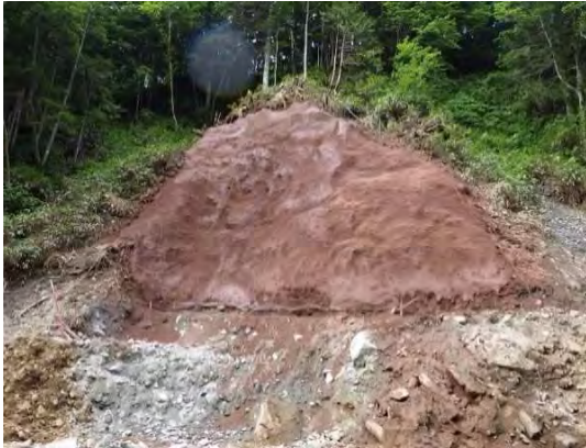
1回目モルタル吹付完了
