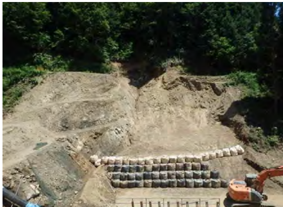
大型土のう設置抑え盛土
