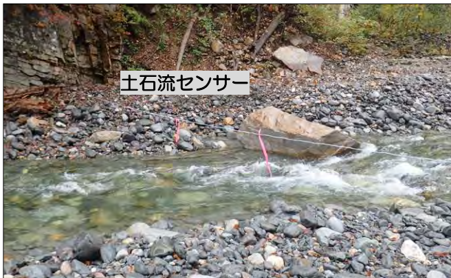
調査地上流(約2.0km)に設置した土石流センサー
