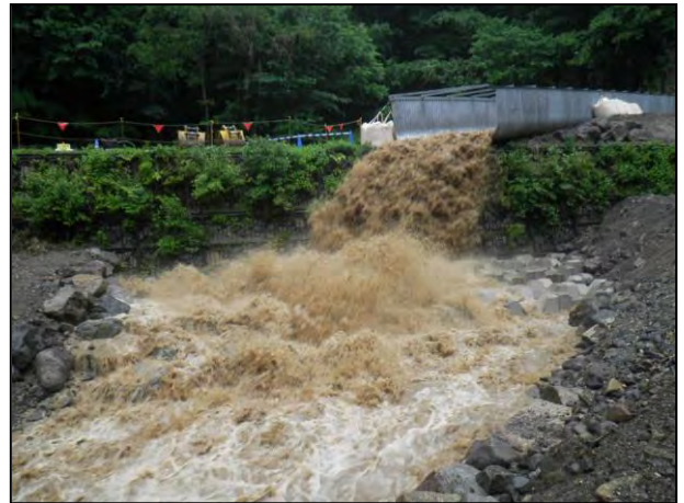
河川出水状況
