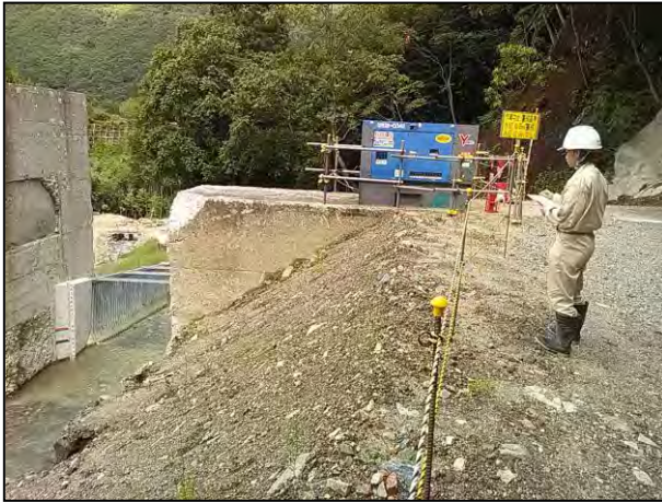
現場巡視（水位観測）
