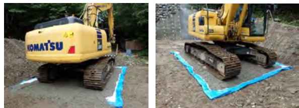
右俣1号オイルフェンス設
