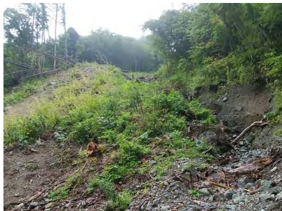
【写真－3 法面崩壊地】
