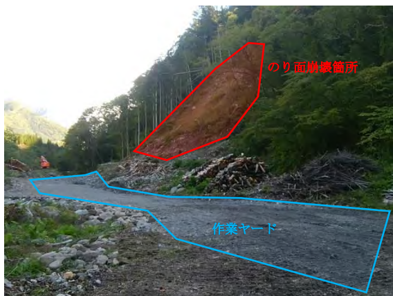
【写真－2 施工場所】
