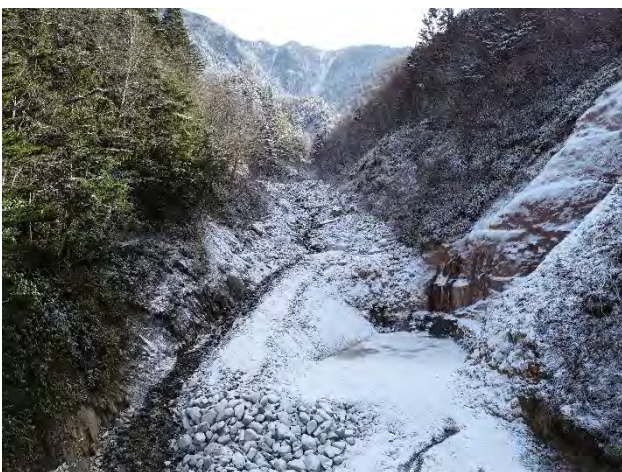
下流より上流を望む
