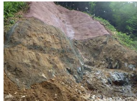
スロープネット設置状況
