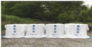
脱枠後のコンクリート構造物に設置する際に、従来の養生マットではなく、弊社が独自に開発した特殊加工による高保水機能を持たせたKWシートで湿潤養生を行う事で、コンクリート表面からの水分の蒸発と拡散を抑制します。これにより、さらなる乾燥収縮によるひび割れの低減と、コンクリート強度の発現に役立ちます。
