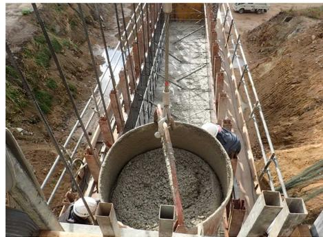
接触事故防止のため型枠組立時に鋼製型枠を側面および前面から設置し背面を後にすることでオペレーターから目視できる作業を行った。また型枠組立作業及びコンクリート打設時に家庭用防犯カメラを設置し、オペレーターから作業範囲がわかる様に工夫した。
