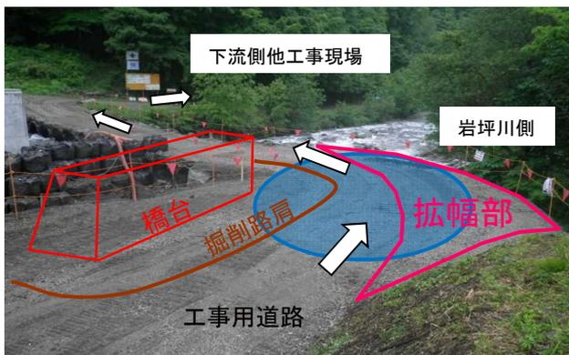
にした。この対策を立案、施工するにあたっては当工事と他工事との間で工事連絡会を設立し、相互の工程や工事内容を調整し順次施工を行い、左記写真のとおり、迂回路の設置で橋台掘削時でも大型車両の通行が可能となった。このとき、橋台工施工完了時には拡幅部と埋戻し部を含め、橋台脇に相当なスペースが出来ることから、ここをクレーンヤードとして
