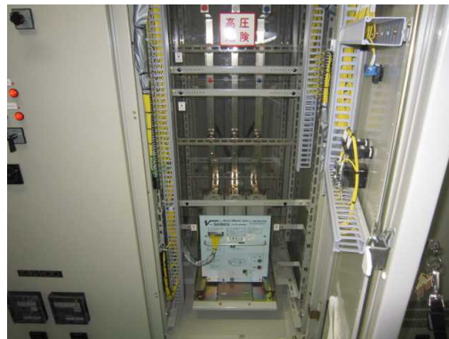
【神通川水系砂防事務所高圧設備一例 (左) 高圧引込受電盤 (右) 発電機切替盤】
