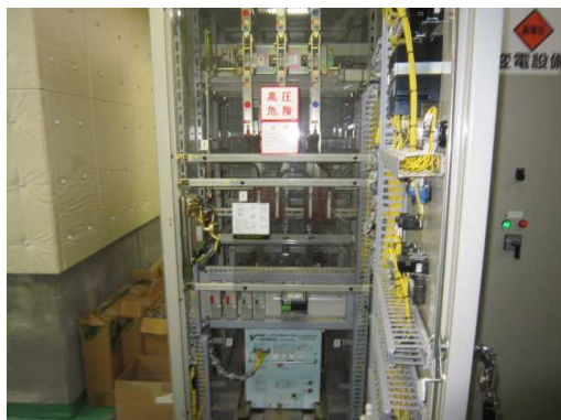
【神通川水系砂防事務所高圧設備一例 (左) 高圧引込受電盤 (右) 発電機切替盤】
