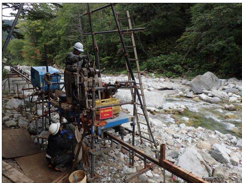
写真 3.2.1. モノレール台車一体型移動式ボーリングマシン（H29年10月 立山砂防事務所 調査業務で採用）
