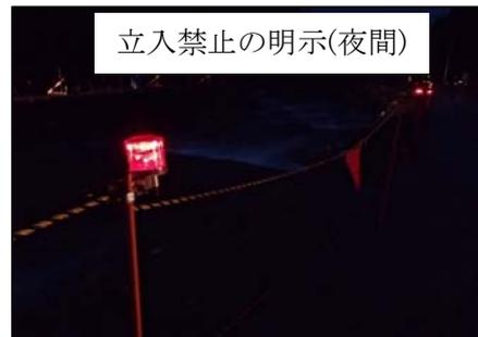
・目で見える安全施設と耳で聞く人感音声センサーの併設により、目と耳から危険だと感じ取ることにより二重に効果があり、第三者への災害防止対策となった。
