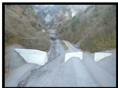
下流より上流を望む
