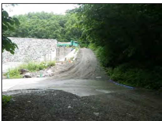
【路面散水状況1】
