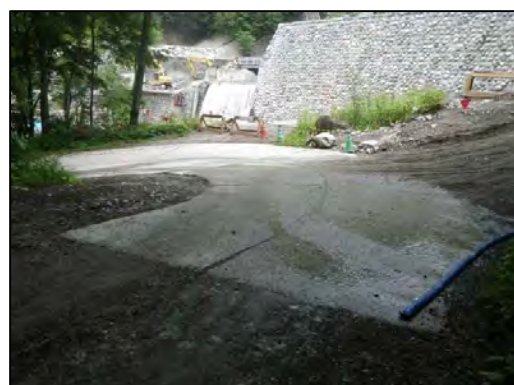
【路面散水状況2】
