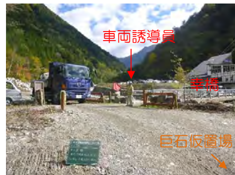
－工事用車両誘導員配置状況－
