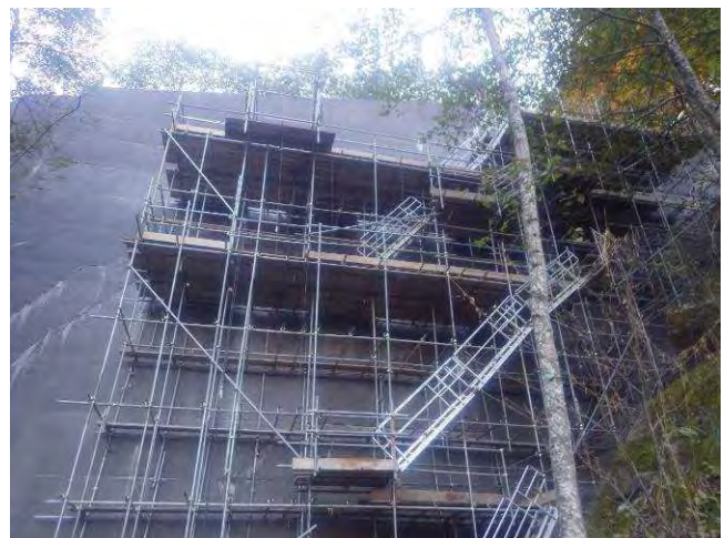
図3.3 リフトオフ足場仮設状況
