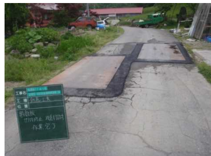
4. 摺付舗装完了
