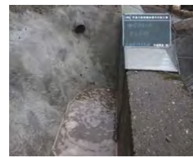
施工範囲外集水場
