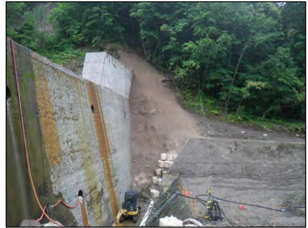
法面保護状況【写真-8】
