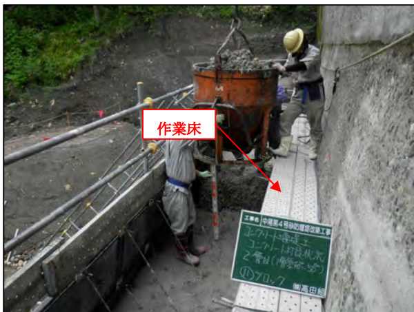
挿入筋を利用した作業床の設置
