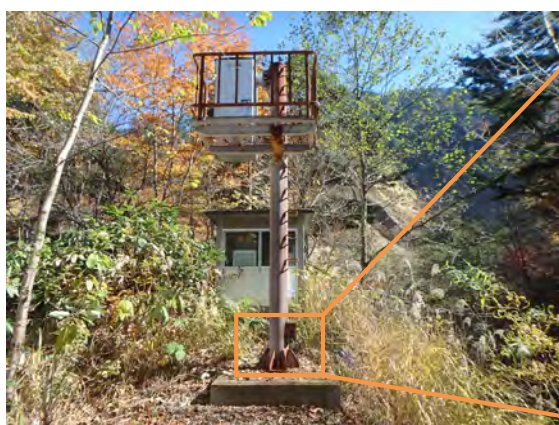
<支柱腐食状況>
