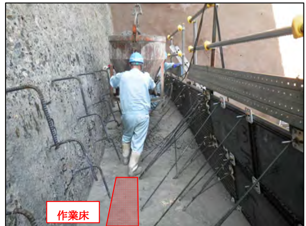
挿入筋加工による作業床の確保
