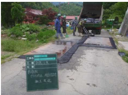
3. 摺付舗装の施工
