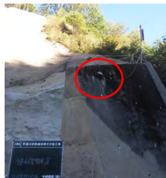
センサー取付状況
