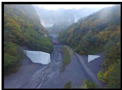
下流より上流を望む
