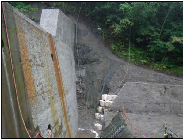
掘削完了時【写真-7】
