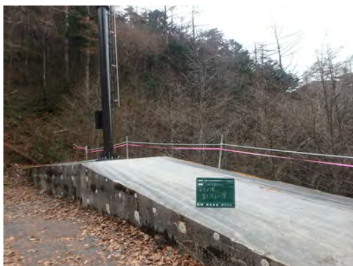
<落下防止対策設置状況>
