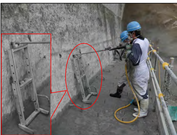
補助器具を使用した削孔状況【写真-5】
