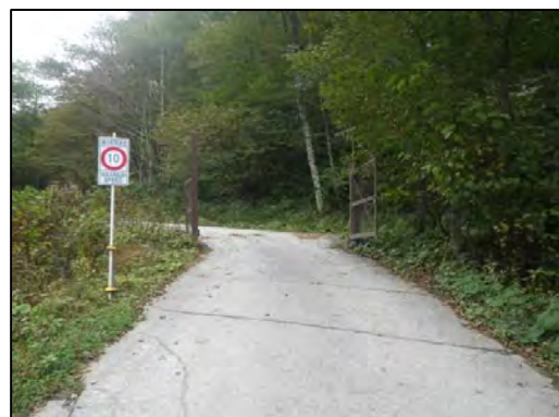
【工事用道路から一般道への合流点】
