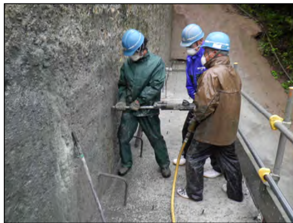
通常の削孔状況【写真-6】
