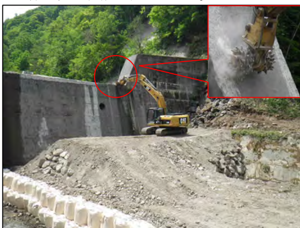
コンクリート切削機械によるチッピング【写真-3】
