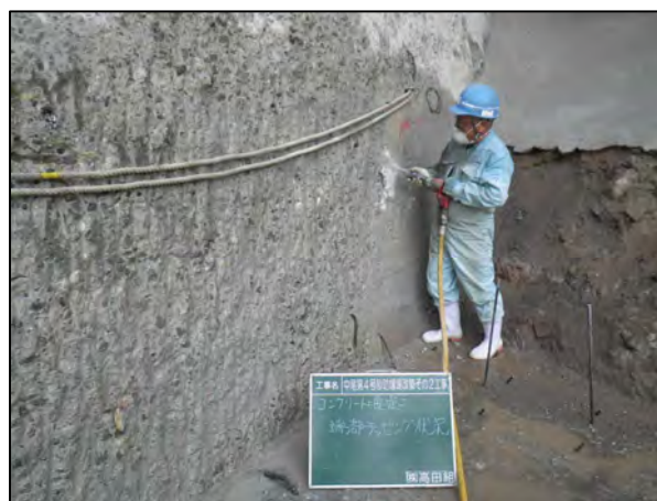
人力によるチッピング状況【写真-4】
