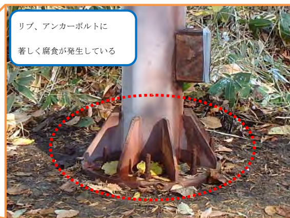
<支柱ベースプレート拡大写真>
