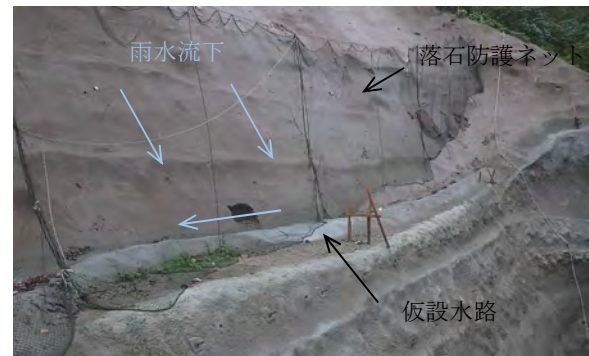
仮設水路及び落石防護ネット（全景）
