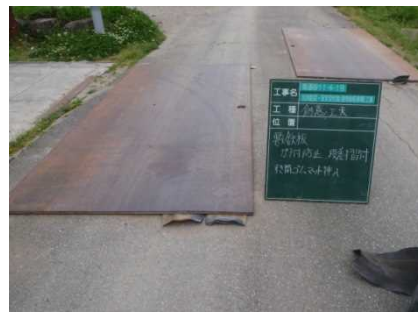
2. 鉄板敷設、ゴムマット挿入
